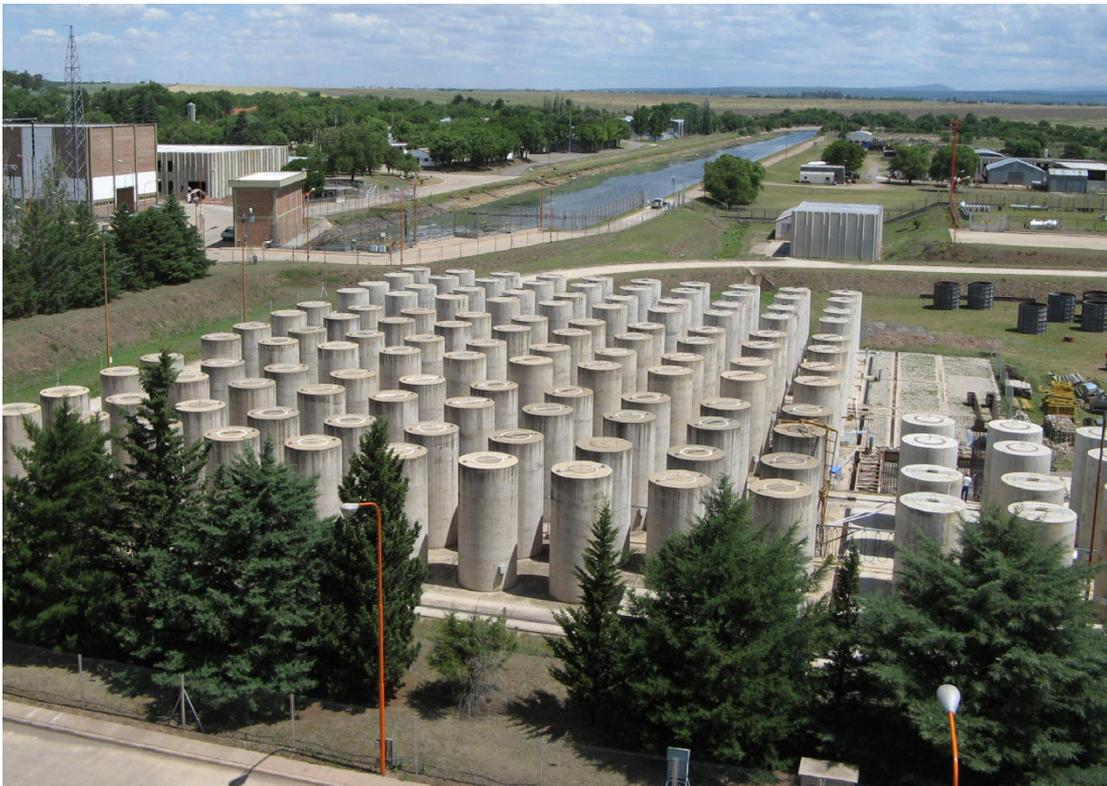
**Figura 1:** Campo de silos con el combustible nuclear gastado de la Central Nuclear Embalse, Argentina.
