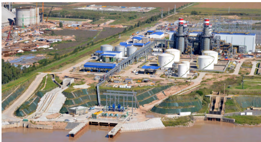
Central Termoelectrica Vuelta de Obligado. Timbúes
