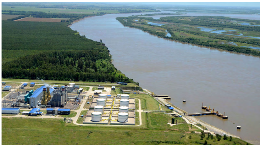
Central Termoeléctrica Gral San Martín - Timbúes
