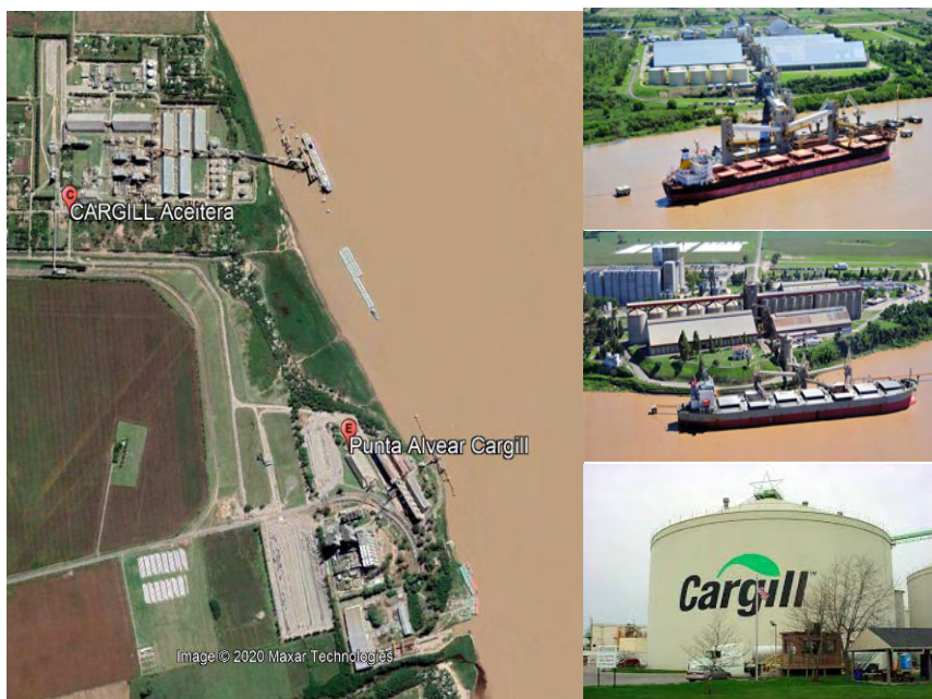
Terminales portuarias de Cargill Villa Gdor Gálvez - Punta Alvear
